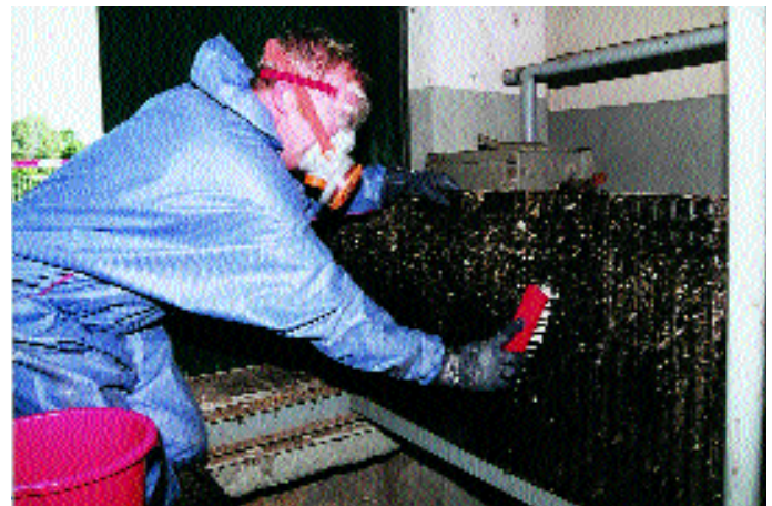
Abb. 11: Reinigung eines durch Taubenkot verunreinigten Treppengitters durch feuchtes Abbürsten
