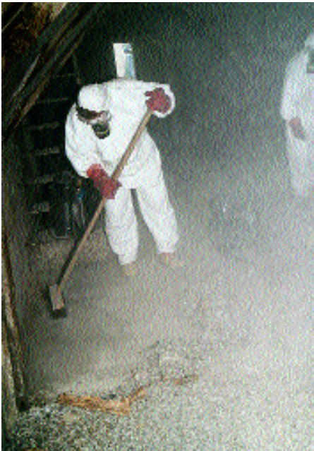
Abb. 3: Reinigungstätigkeit auf einem mit Taubenkot verunreinigten Dachboden. Beim Fegen des getrockneten Kots entstehen erhebliche Staubmengen. Die Arbeitnehmer sind mit Einmalschutzanzügen, Sicherheitsstiefeln, wasserundurchlässigen Handschuhen sowie Atem- und Augenschutz ausgestattet. (Foto: A. Albrecht)
