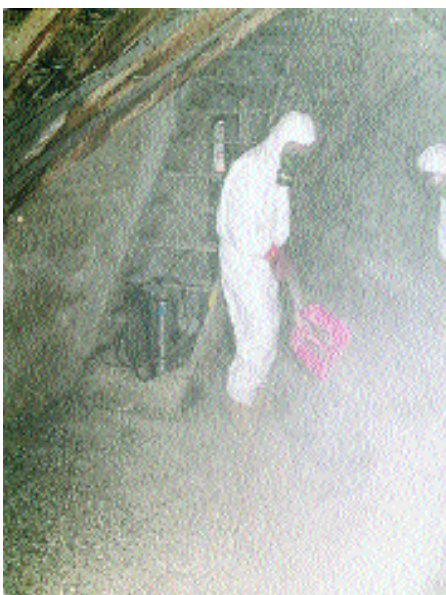
Abb. 9: Ein mit Taubenkot verunreinigter Dachboden in Koblenz. Der Fußboden war teilweise bis zu 1–2 cm Höhe mit überwiegend trockenem Taubenkot bedeckt. Vor Beginn der Reinigung befanden sich einzelne Tauben in den Räumlichkeiten. Auf dem Bild ist eine typische Reinigungstätigkeit zu sehen, in dessen Verlauf sehr viel Staub in die Luft gelangte
